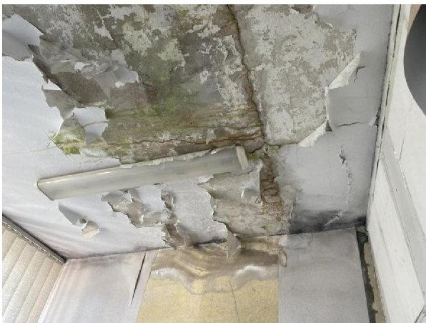
Zdj. nr 5 i 6. Stropodach pokryty papą i sufit stropodachu – nieszczelny, widoczne ślady zalewania wodą deszczową.
