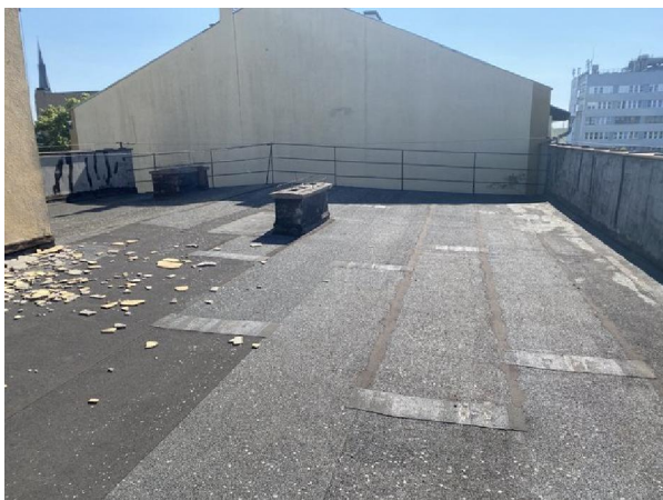
Zdj. nr 5 i 6. Stropodach pokryty papą i sufit stropodachu – nieszczelny, widoczne ślady zalewania wodą deszczową.
