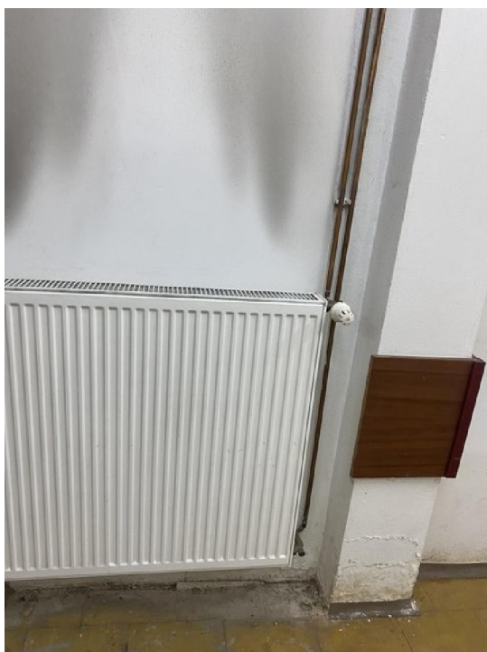
Zdj. nr 7 i 8. Ściany pomieszczeń w piwnicy, widoczne ślady podciągania wilgoci. Grzejniki płytowe, stalowe, oświetlenie pomieszczeń świetlówkami.
