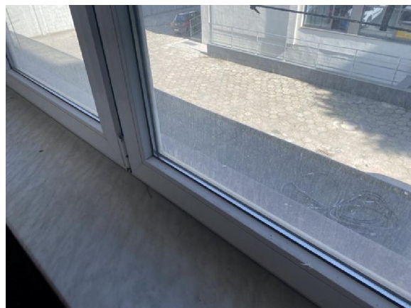
Zdj. nr 11 i 12. Stolarka okienna na profilach PCV z przeszkleniem zespolonym oraz drewniana jedno i dwuszybowa, kilkudziesięcioletnia
